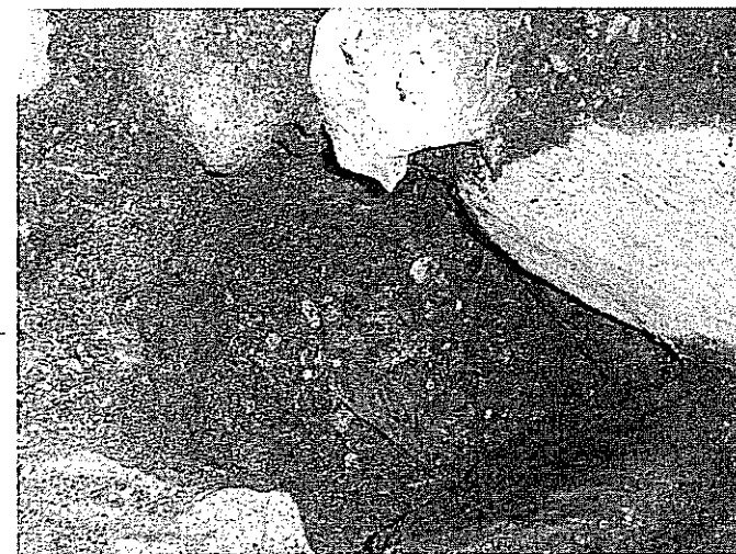
fig. 4 - Particolare di una buca per l'inserimento di un palo in legno per l'alzata.
