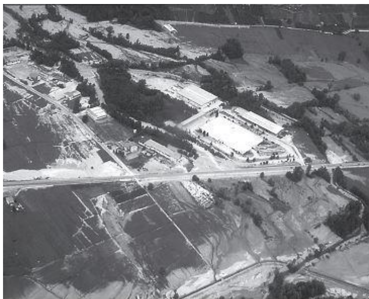
Figura 7 - Alluvionamenti nella zona di Ponte in Valtellina (foto Dott. Roberto Potenza).
