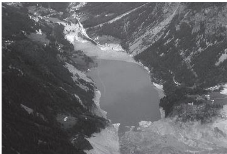
Figura 30 - Vista aerea del lago di Val Pola. Si possono osservare lo sbarramento del corso del Fiume Adda generato dall'accumulo di frana, il materiale frottante sulla superficie del bacino, l'abitato di Aquilone in sponda sinistra del lago (Foto Dott. Roberto Potenza).
